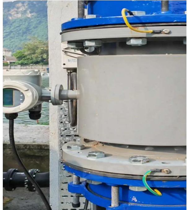
Elektromagnetni merač protoka na dovodnom cevovodu | elektromagnetni protokomer na prirubničkoj vezi
