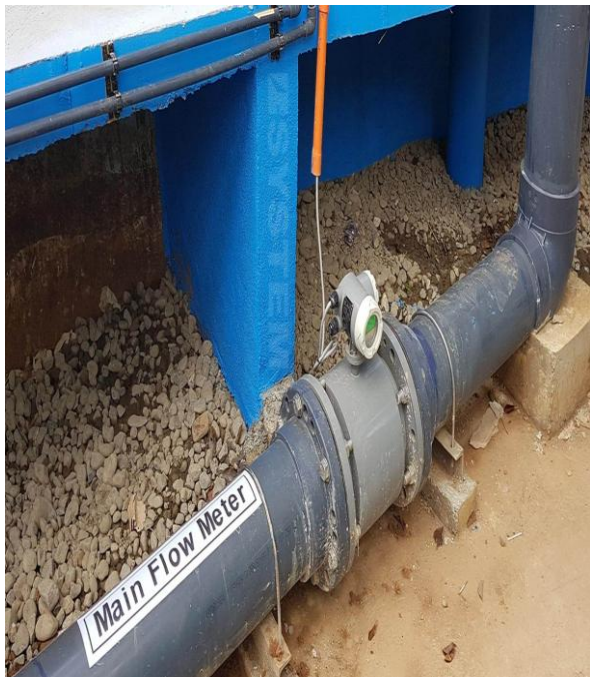
Elektromagnetni merač protoka na dovodnom cevovodu | elektromagnetni protokomer na prirubničkoj vezi
