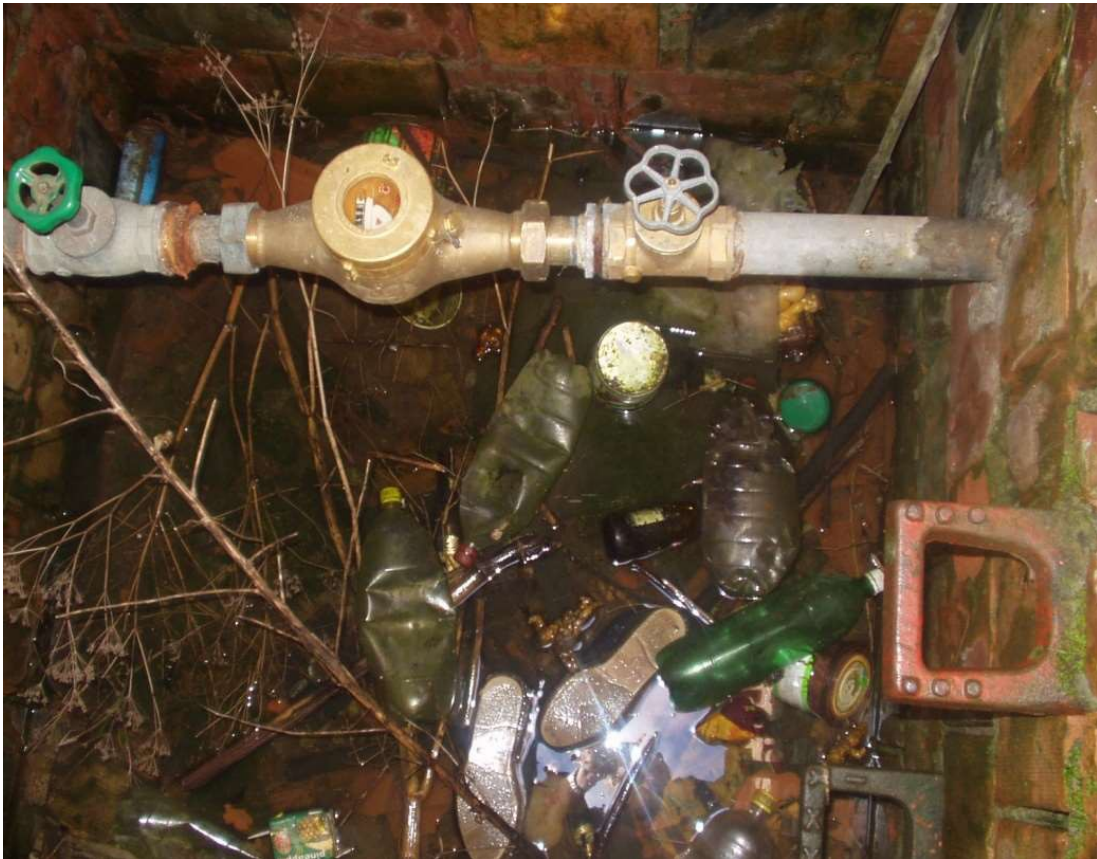
Slika 3. Primer mernog mesta sa neodržavanim skloništem i povećanim rizikom od netačnog rada vodomera.
