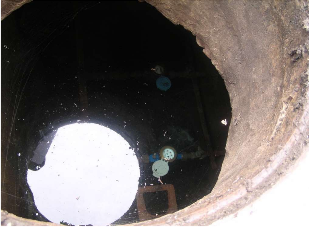
Slika 4. Potopljeno vodomerno sklonište kao primer uslova koji ugrožavaju čitanje, održavanje i pouzdanost komunikacionog sklopa.
